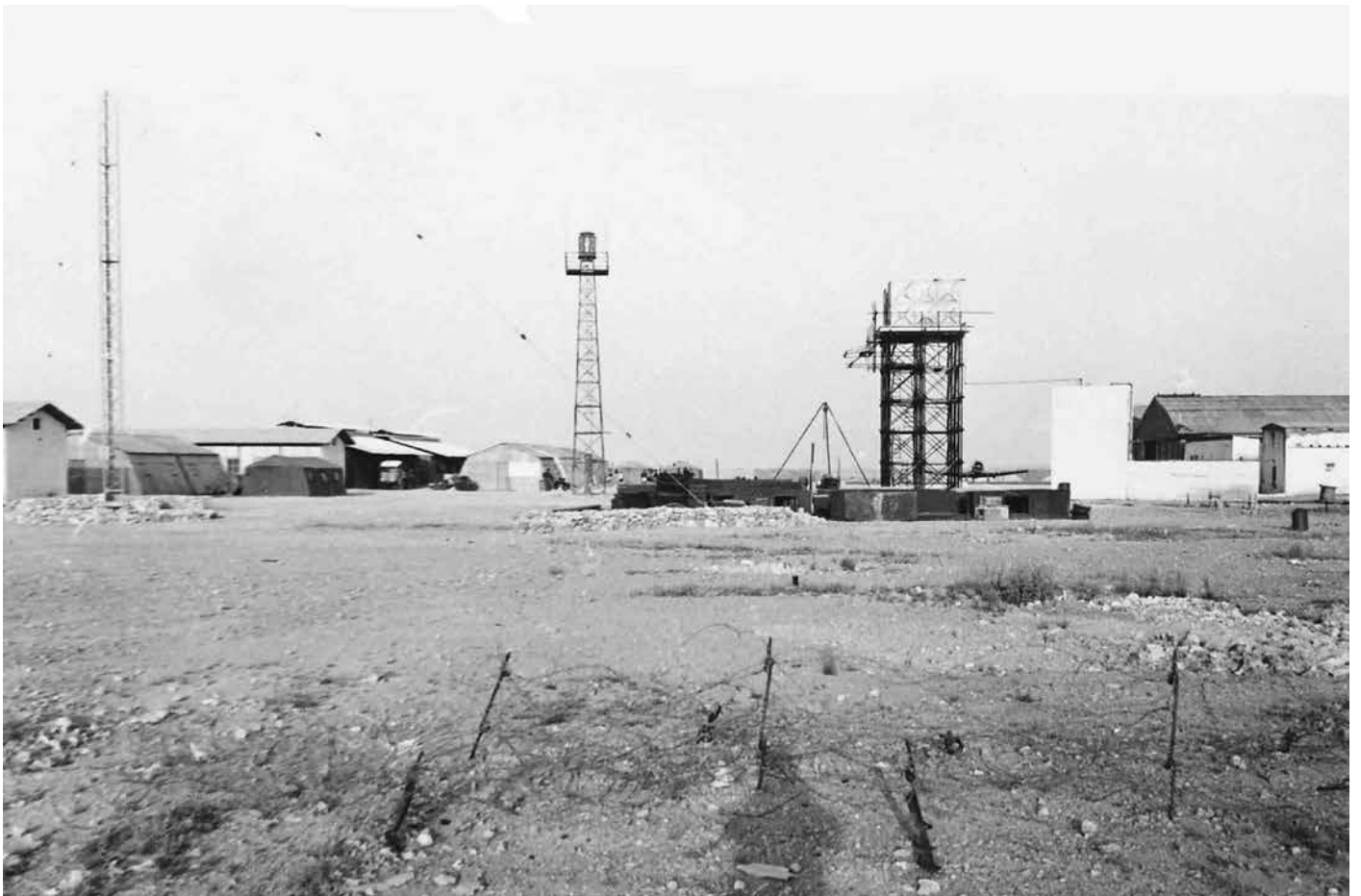
▼ Les deux châteaux d'eau
